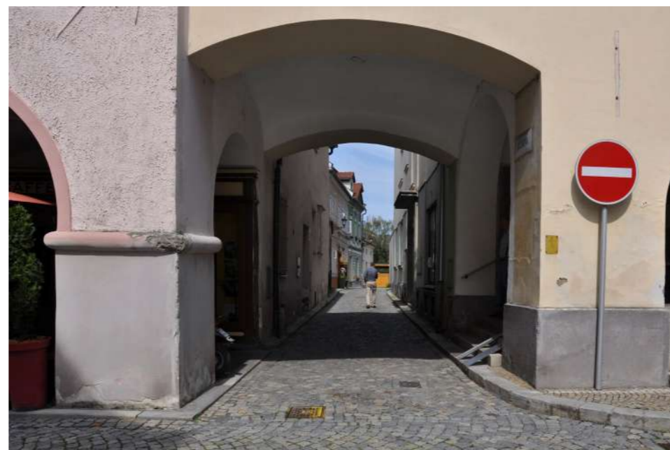
Vnitřní okruh - průchod Křižíkova
