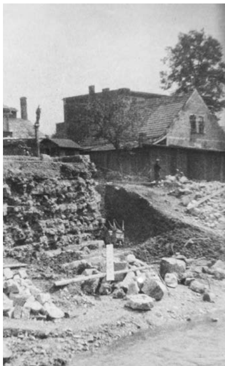
Oprava poškozeného mostu mezi Novým Jičínem a Žilinou.
