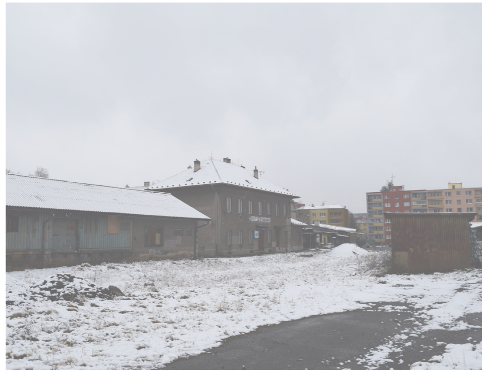
bývalé kolejiště s nástupištěm
