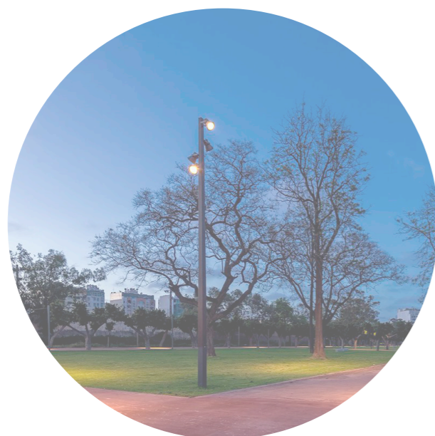
reflektory osvětlující pumtrack a pobytové plochy
