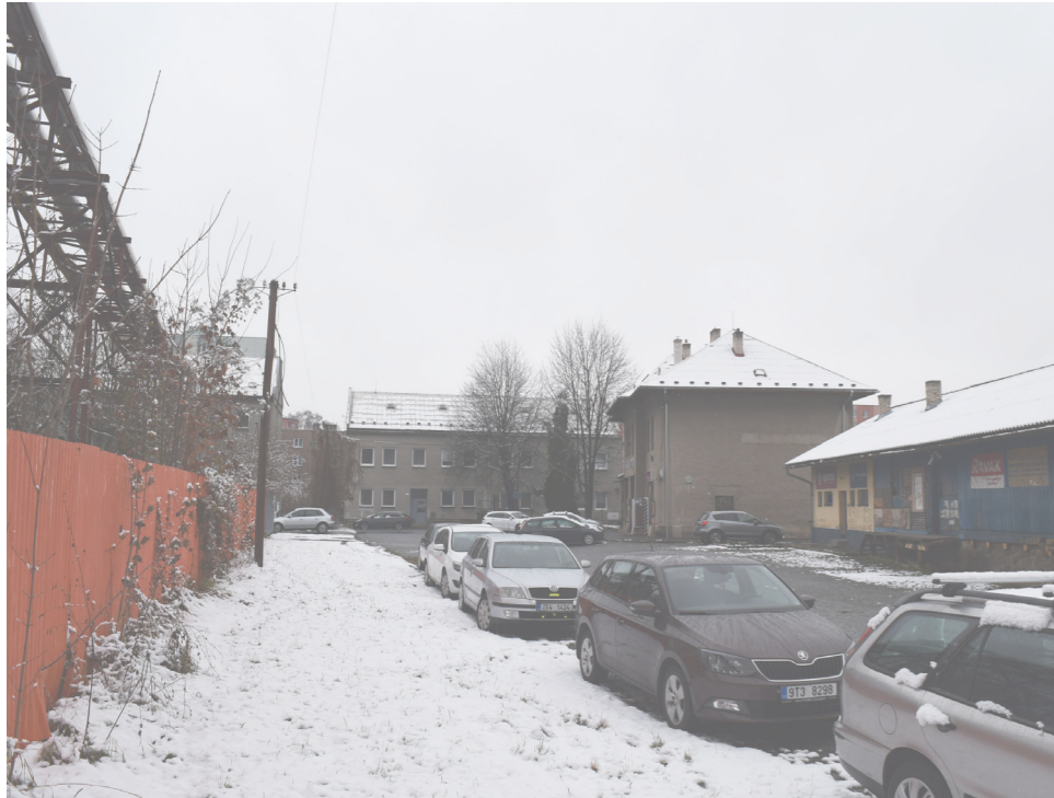
obytné domy v ulici Nádražní, tovární plot, budovy bývalého nádraží a skladu
