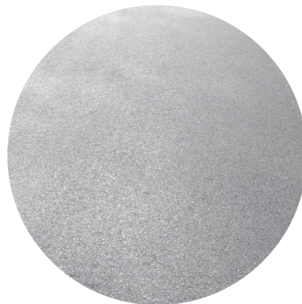
tmavý asfalt chodníků, cyklostezky a pumptracku
