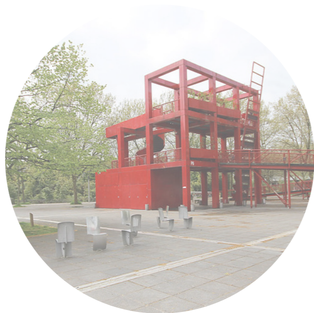
jasně barevná konstrukce přístřešku
