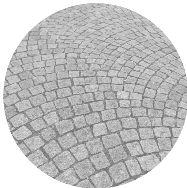
přeskládaná kamenná dlažba
