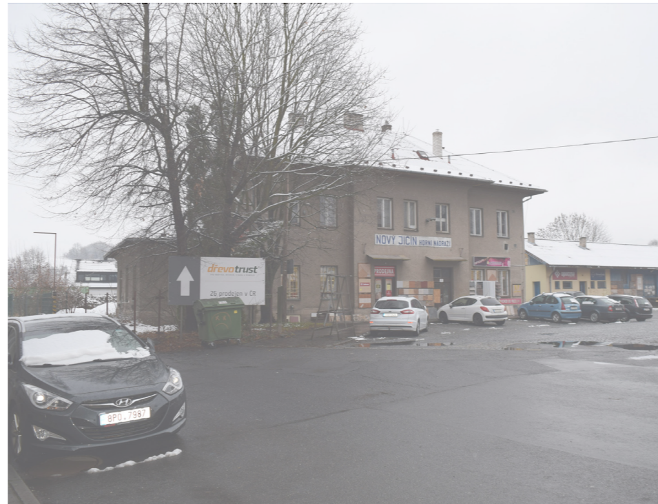
budova bývalého Horního nádraží
