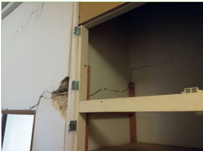
Detailní záběr na praskliny, které se objevily ve zdech novodobé přístavby Beskydského divadla, dokončena byla v roce 1992. Foto: Marie Machková
