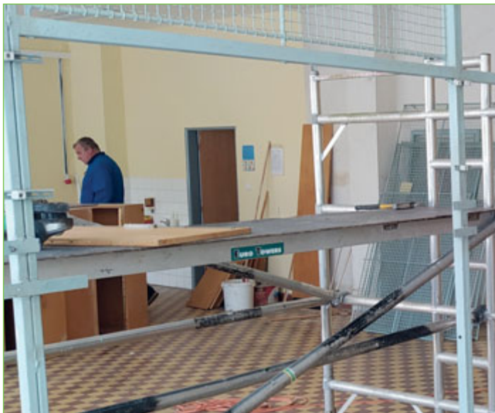
Do července se tyto prostory školy promění v moderní učebnu technických předmětů. Foto: Ladislav Gróf
