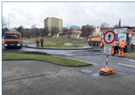
■ Rekonstrukce pěti okružních křižovatek.
