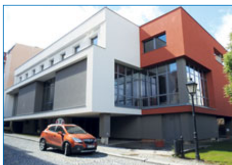
■ Přístavba Hotelu Praha s novým pláštěm.
