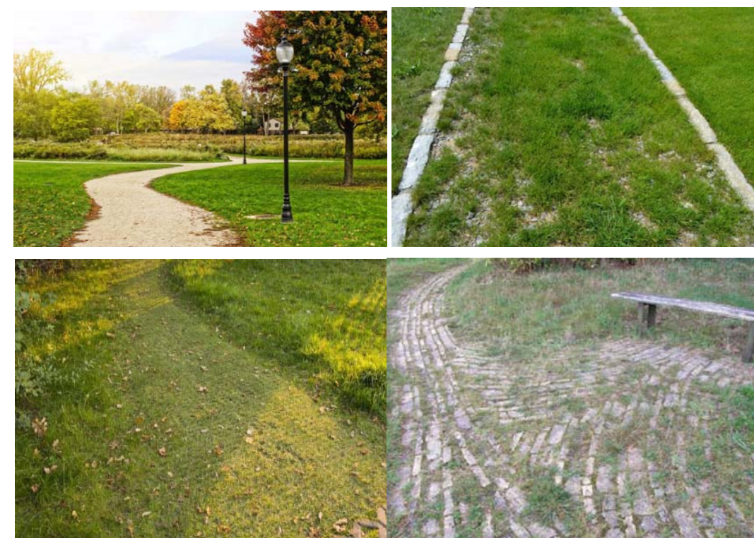
Obr. Úprava pěšin a prostupů pro pěší (mlatová úprava, šterkový trávník, drenážní dlažba)
