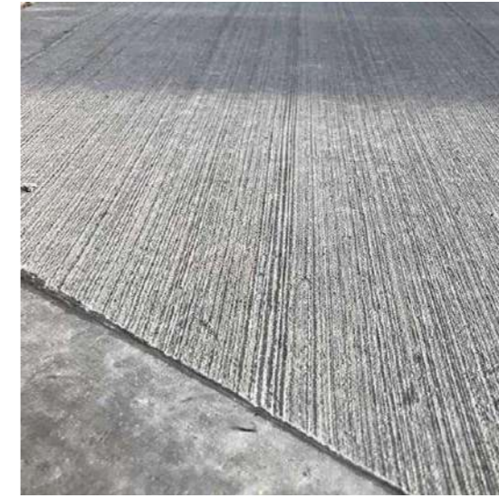
probarvený asfaltobeton, kartáčovaný beton
