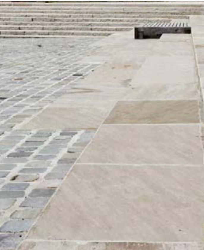
↑ ↑ Hlavní materiál placu - Oblé dlažební kostky z lokálního kamene (viz Štramberk, Příbor) ↑ Dlažba v prostoru kolem sochy Palackého - hladká velkoformátová dlažba.
