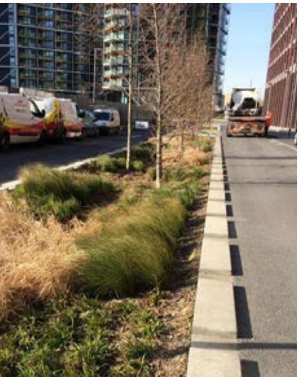
↑ Plocha odvodňující přilehlé zpevněné povrchy ↓ Svejl, do kterého je skrz děrovanou obrubu svedena voda z chodníka a vozovky
