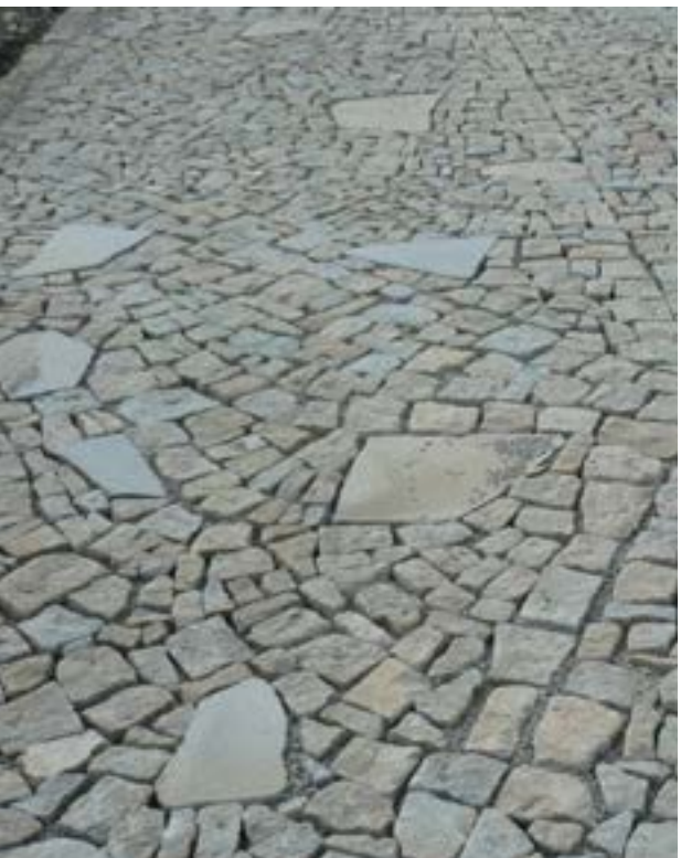
↑ Betonová dlažba - štěrkem vysypané spáry ↓ Kamenná dlažba s drenážní spárou
