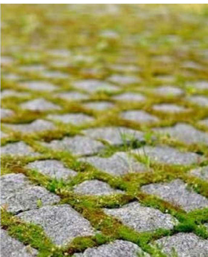
Polopropustné parkovací plochy ↑↑ varianta beton ↑ varianta kámen
