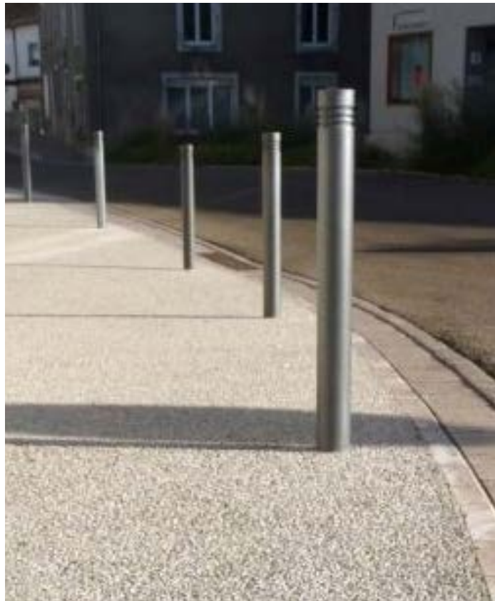
↑ ↑ Materiál vozovky I/57 - probarvený beton ↑ Sloupky podél silnice.
