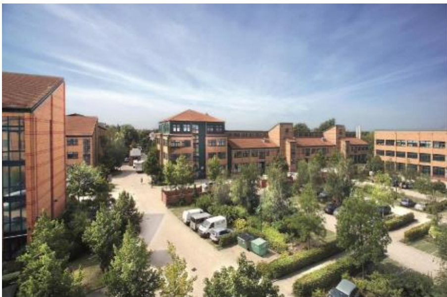
Revitalizace brownfields ( https://ct24.ceskatelevize.cz/regiony/1929104-z-arealu-byvale-zbrojovky-bude-za-deset-let-moderni-brnenska-ctvrt )
