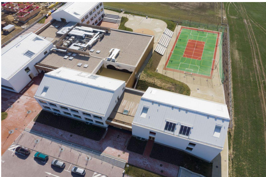
Světlé střechy. ( https://www.asb-portal.cz/stavebnictvi/strecha/stresni-krytina/plechova-krytina/proc-se-bila-barva-strech-stane-mozna-stejne-oblibena-jako-u-aut )
