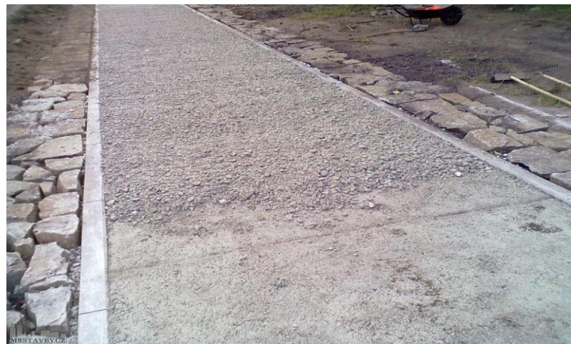
Mlatový povrch. ( https://www.msstavby.cz/mlatove-komunikace-u-ostavice-05-09-2012/ )
