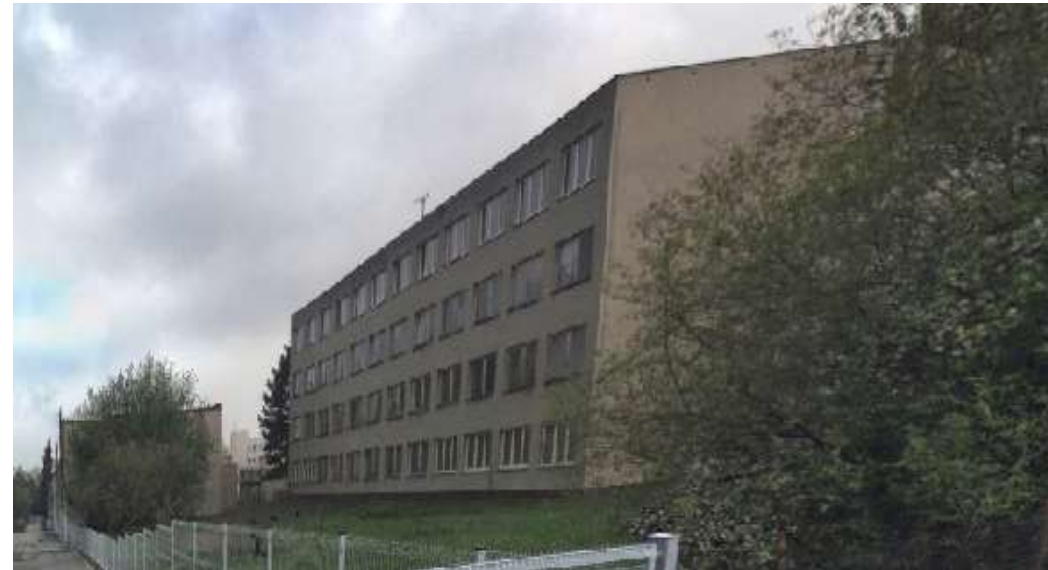
foto: stávající stav
