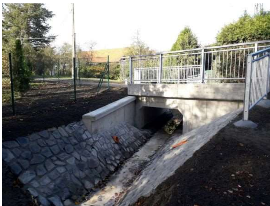
Nově dokončena rekonstrukce propustku na komunikaci vedoucí ke hřbitovu v místní části Straník
