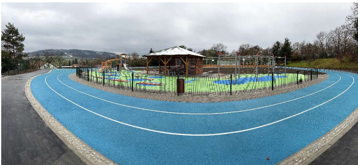
Rekonstrukce hřiště na Dlouhé ulici
