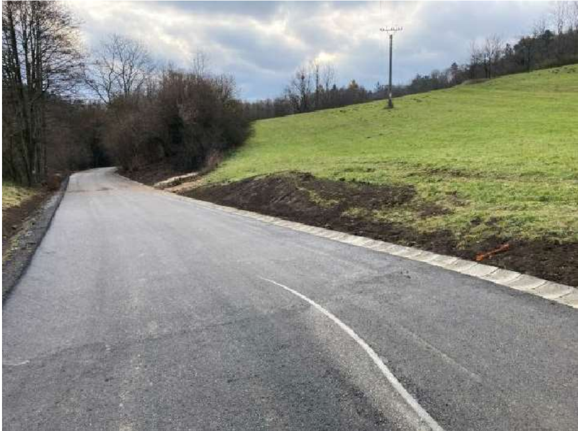
Dokončena oprava místní komunikace mezi Kojetínem a Straníkem u Nového Jičína
