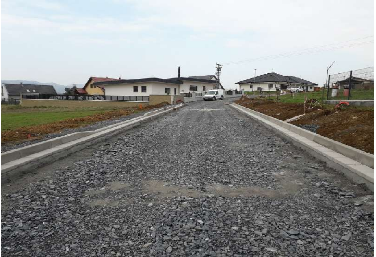
Nově dokončené inženýrské sítě včetně komunikace pro výstavbu rodinných domů v Žilině Za Školou
