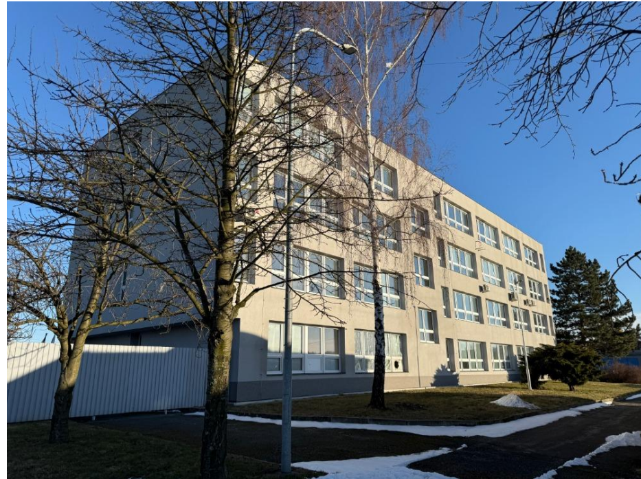
2024 zateplení fasády, nová okna a dveře
